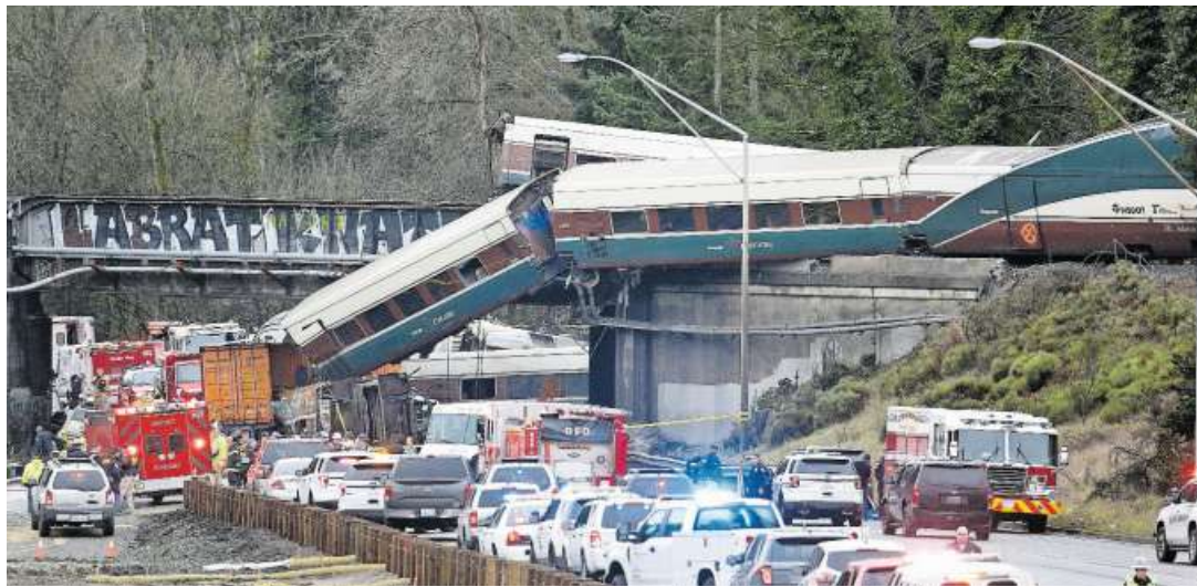
Der Zug 501 war in der Nähe der Ortschaft DuPont Richtung Süden unterwegs, als er entgleiste und auf den Highway Interstate 5 kippte.
